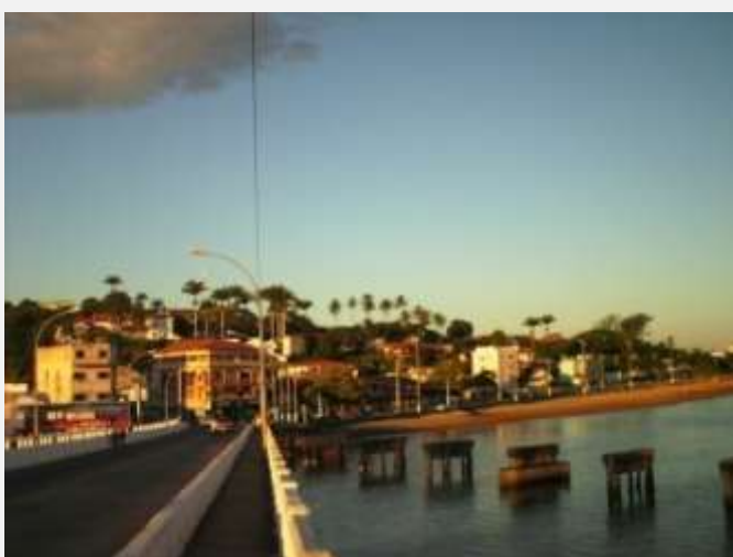
Fotografia 28c- Ponte do rio Benevente- 2010
