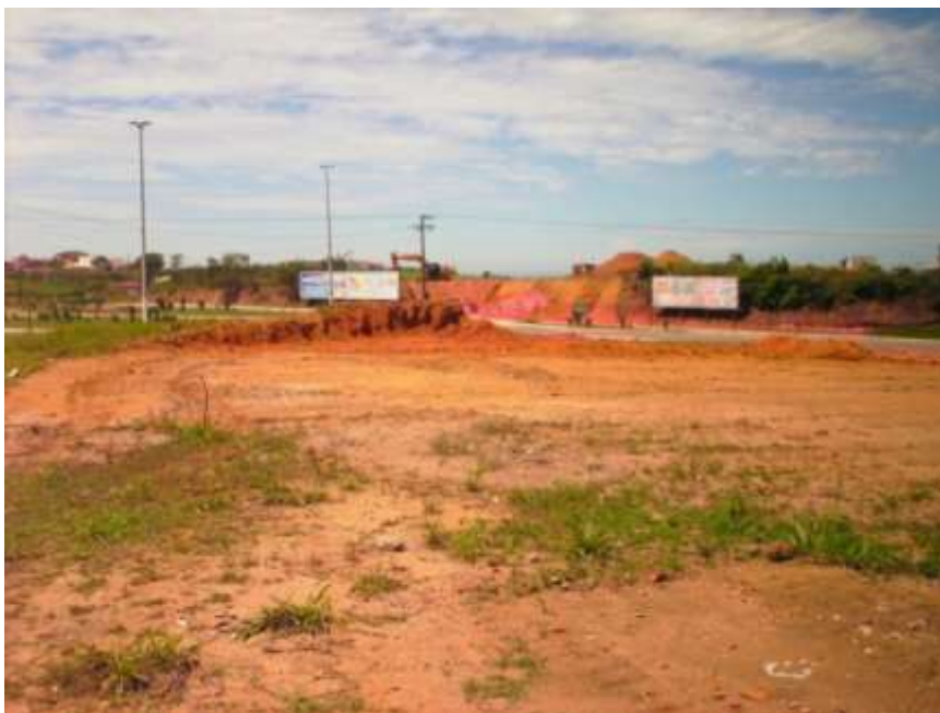
Fotografia 23- Gasoduto – Ubu- Rodosol – Recanto do Sol
